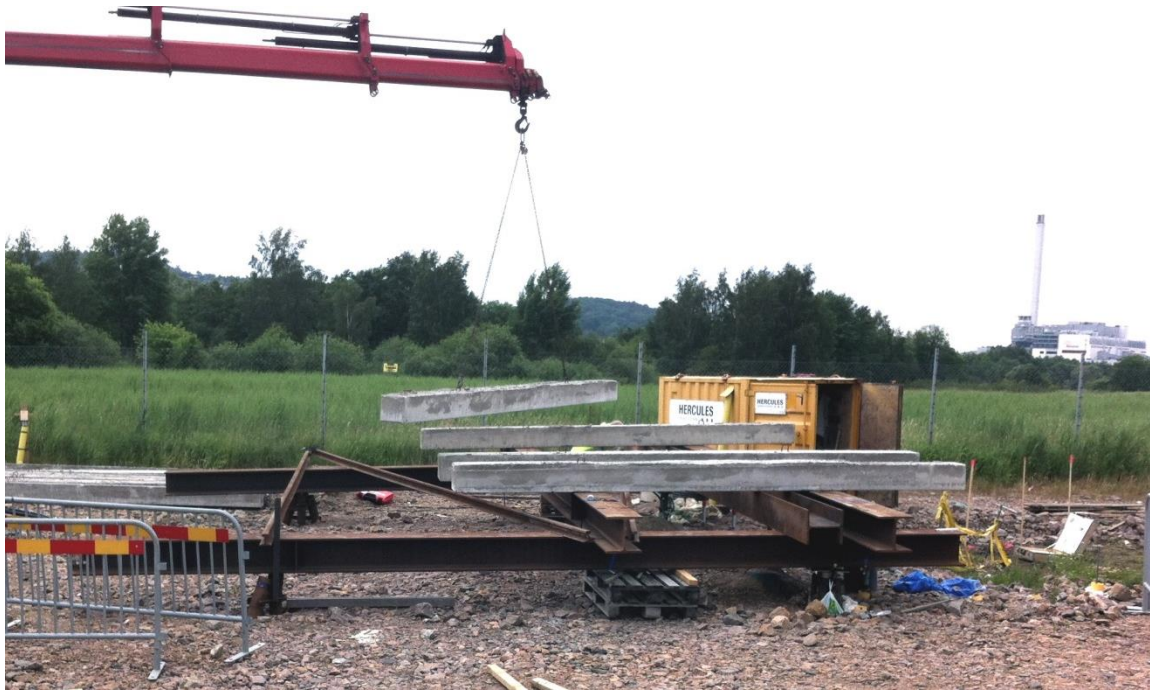
Figur 1. Pålastning av statisk belastning motsvarande brukslast. Betongelementen är 5 m långa. Försökspålar av stål finns under den högra kanten av lastriggen. Försökspålar av betong står utanför bild.
